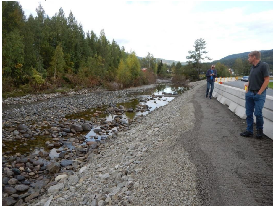
Bilde 1: Skader på Fv. 250. Mangler erosjonssikring. Ansvar fylkeskommunen. NVE gav praktiske råd til gjennomføringen og bruk av NVEs sikringshåndbok.
