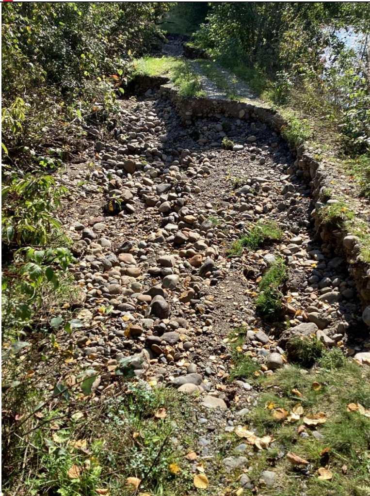
Bilde 4: Brudd på flomvollen over en lengde på ca. 25 m.
