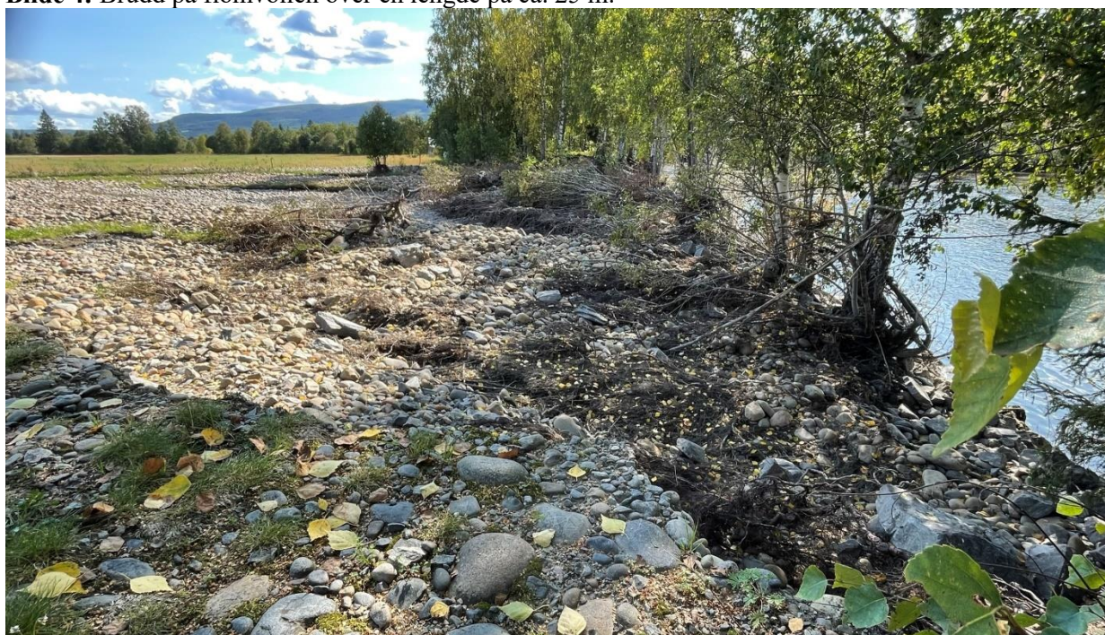
Bilde 4: Brudd på flomvollen over en lengde på ca. 25 m.
