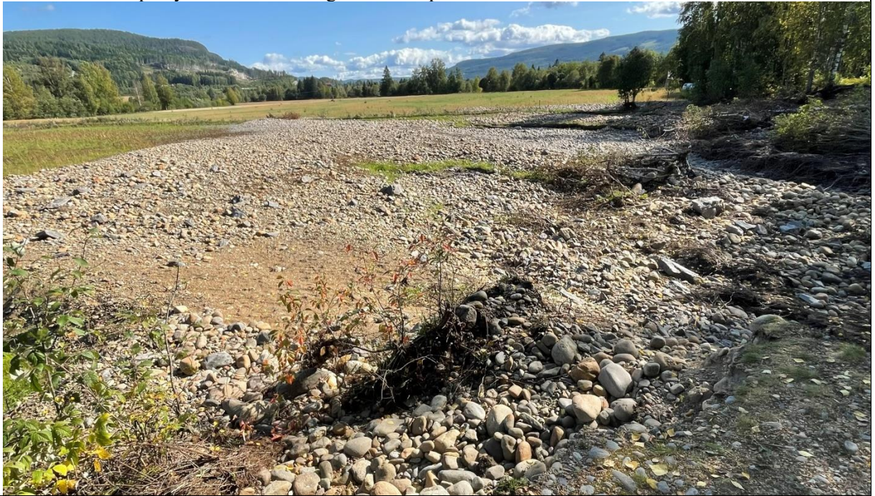
Bilde 5: Skader på dyrka mark som følge av brudd på flomvollen
